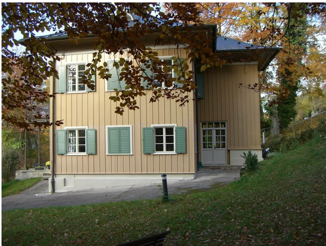
La facciata sud dell'ex villa Weinmann a Leoni come si presenta oggi.
